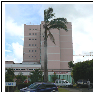
Fig 1. Vue générale blocs A et B
