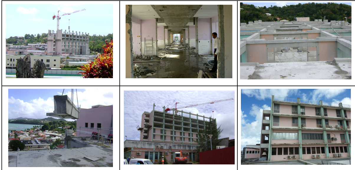
Fig 12 à 17. Différentes phases de la déconstruction
