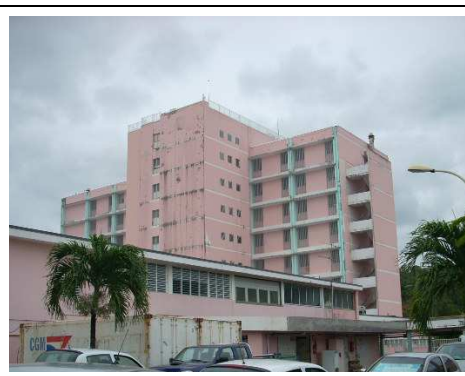
Fig 2. Vue générale blocs A, B et C
