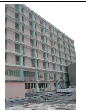
Fig 3. Façade blocs B- C
