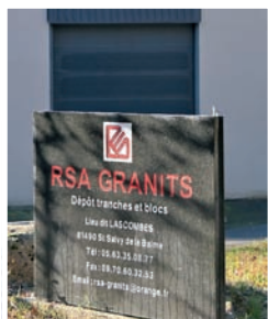
Vue extérieure du dépôt de tranches de RSA Granits construit en 2013.
