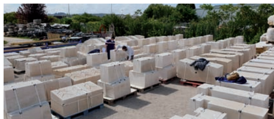
Stocks d'éléments destinés au chantier de Saint-Dizier, chez Rocamat et SNBR. Cette dernière a réalisé les sciages de tous les claveaux. Ceux destinés aux grands arcs ont une légère forme en "S" notamment afin d'agrandir leur surface de contact. Plus de 1 000 morceaux ont été nécessaires à la construction de l'enceinte.
