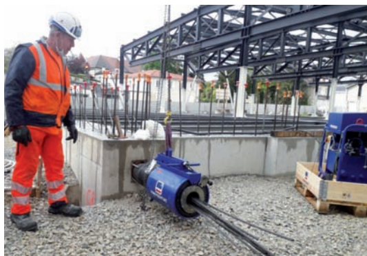
Les culées et longrines en béton qui supportent les grands arcs ont été précontraintes par les techniciens de l'entreprise spécialisée Freyssinet.
