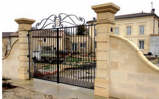
Pierre de parements pour deux façades mise en œuvre collée et agraphée.
