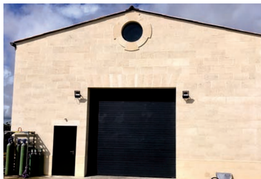
Pierre de parements pour deux façades mise en œuvre collée et agraphée.
