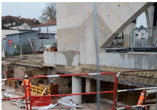
Les culées et longrines en béton qui supportent les grands arcs ont été précontraintes par les techniciens de l'entreprise spécialisée Freyssinet.
