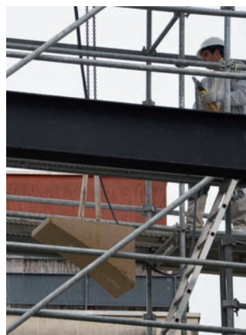
Détail sur les travaux de mise en œuvre de la pierre, réalisés par SNBR avec des moyens de manutention très adaptés, notamment le treuil monté sur l’échafaudage qui circule sur toute la longueur du bâtiment.
