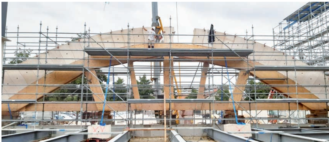
Les grands arcs des façades Est et Ouest de 23 m de portée sur leur coffrage fabriqué par SNBR. Ils créeront un large auvent avant d'entrer véritablement sous le marché couvert. Les claveaux des grands arcs mesurent 110/140/170 x 66 x 60 cm. Les dimensions principales des pierres de remplissage sciées 6 faces sont : 140 x 70 x 60 cm au-dessus des grands arcs.
