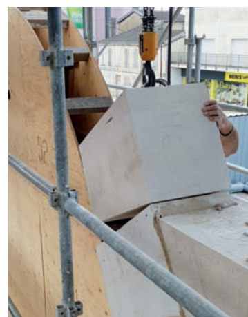
Détail sur les travaux de mise en œuvre de la pierre, réalisés par SNBR avec des moyens de manutention très adaptés, notamment le treuil monté sur l’échafaudage qui circule sur toute la longueur du bâtiment.
