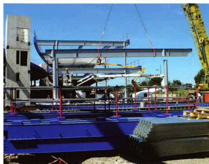
^ Des profilés du commerce pour poutres longitudinales. v Levage et mise en place d'une poutre transversale.
