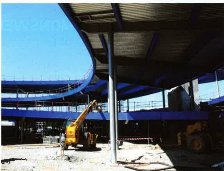
^ Poutres de rive cintrées en caissons soudés. v Un tablier en plancher collaborant sur bac acier.
