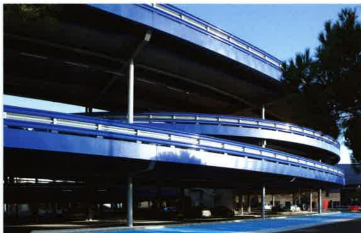
^ Poutres de rive cintrées en caissons soudés. v Un tablier en plancher collaborant sur bac acier.
