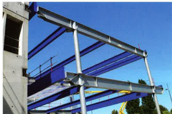
^ Des profilés du commerce pour poutres longitudinales. v Levage et mise en place d'une poutre transversale.
