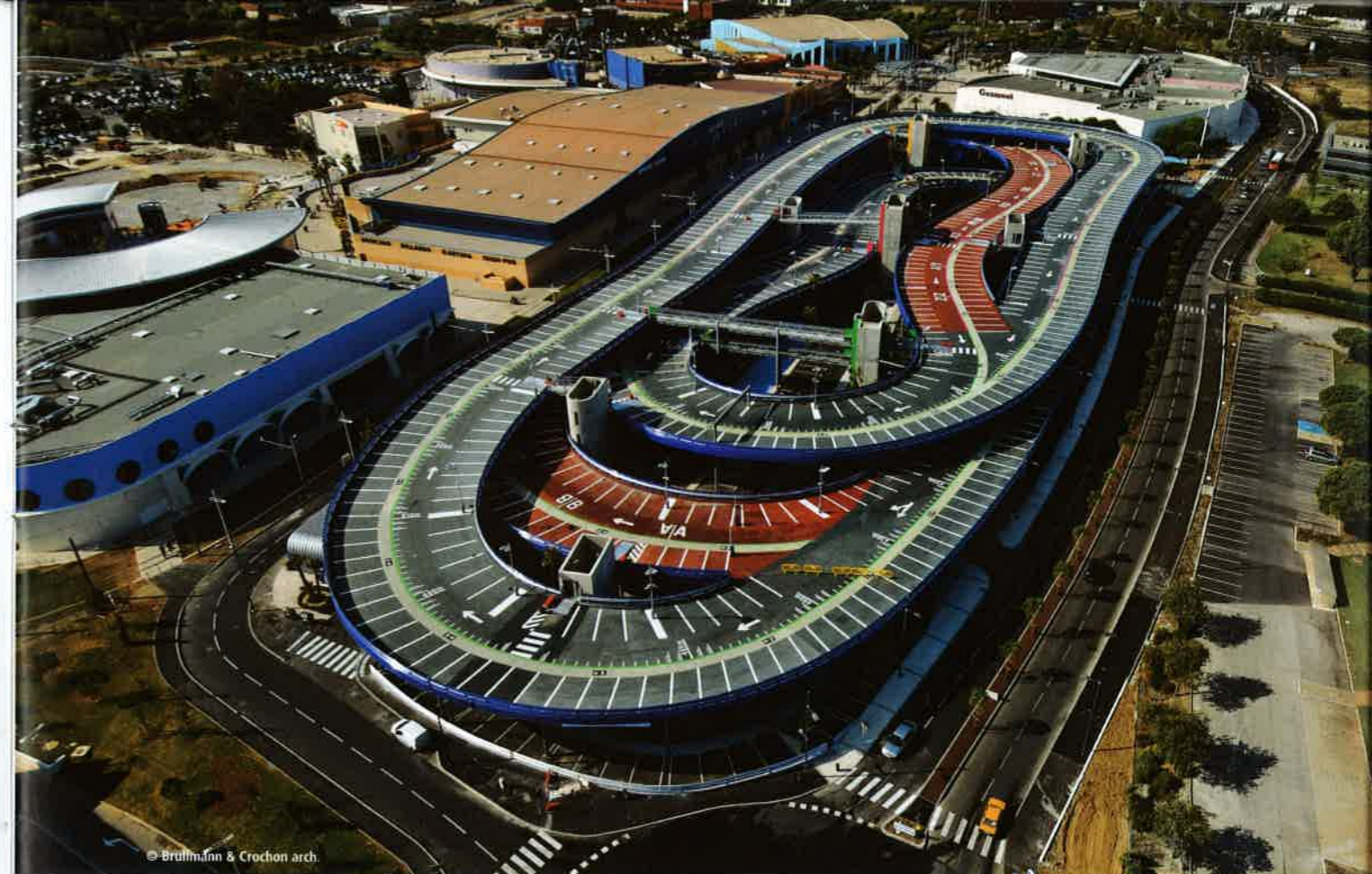
Un parking déroulé en circuit et doté d'une signalétique de ruban métrique.
