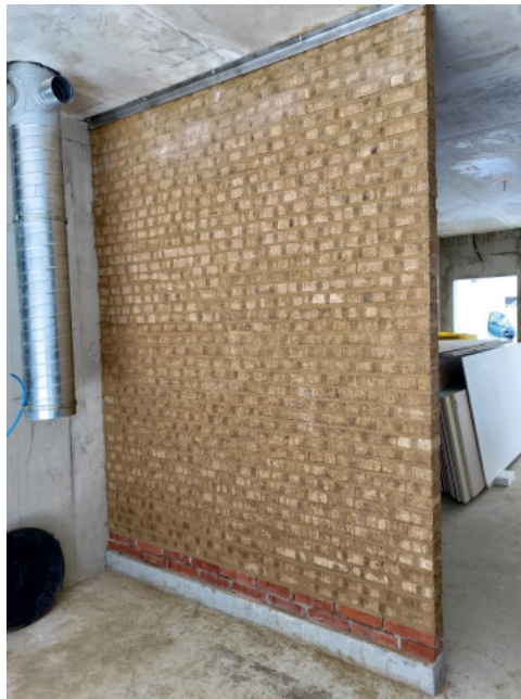
Exemple d'une cloison intérieure en briques de terre crue extrudées - ©ekopolis
