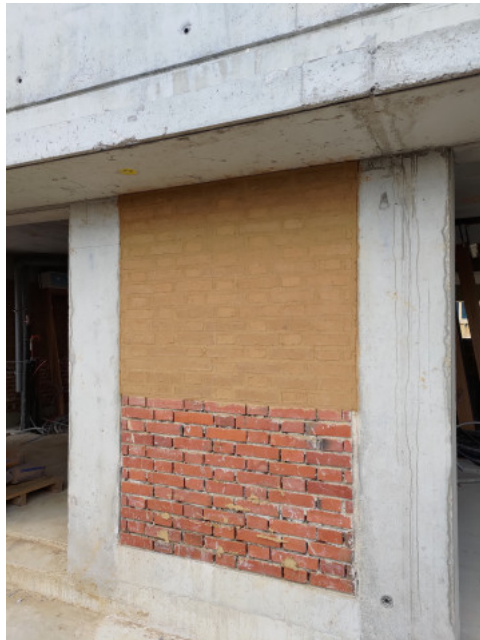
Les briques de terre crue des murs situés en attique sont remplacées par des briques de terre cuite pour les protéger des intempéries - ©ekopolis
