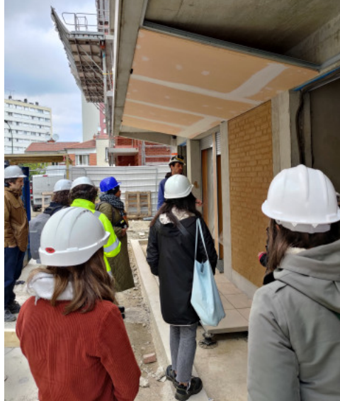
Les débords de dalle des balcons protègent les murs en briques de terre crue des intempéries - ©ekopolis
