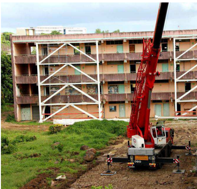
Bâtiment renforcé – vue en élévation
